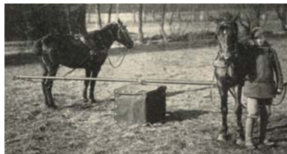
Der Göpeldynamo von Siemens & Halske im Einsatz, 1907
