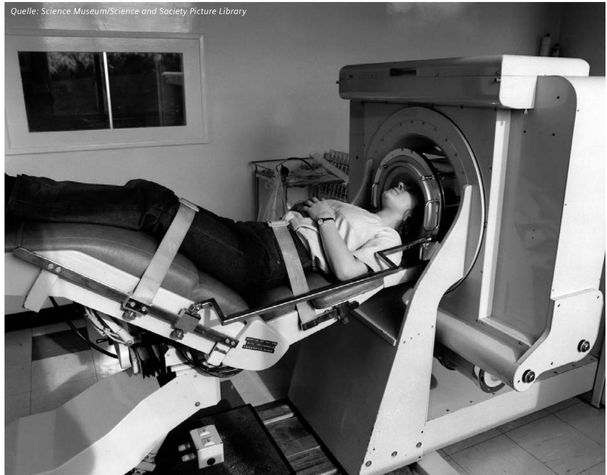
Der Prototyp des ersten Computertomographen verändert die weitere Entwicklung der Röntgentechnik
